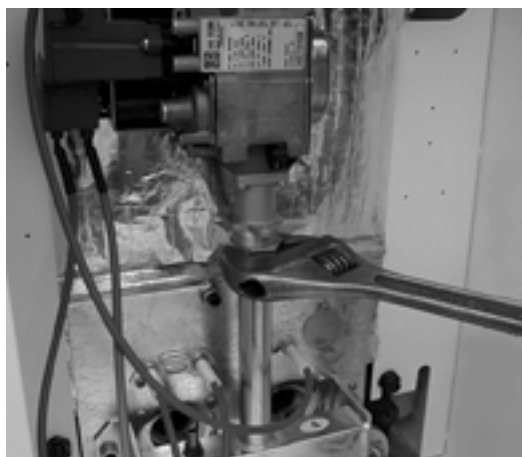
Foto L: Sconnessione rampa gas Foto L: Desconexión de la rampa del gas
